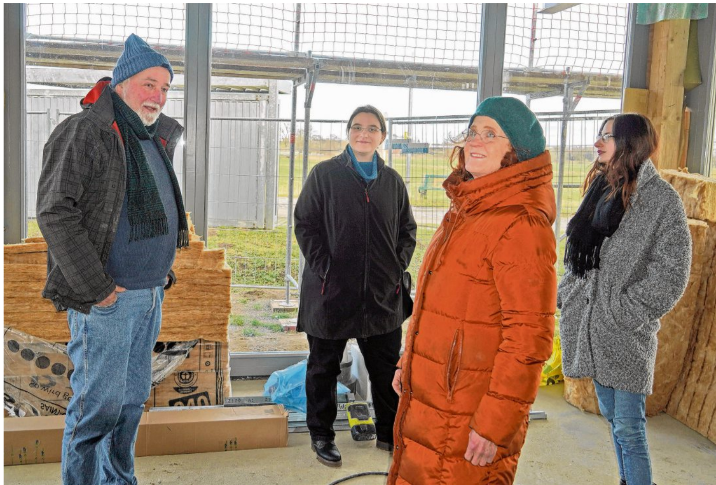
Die beiden Schlosseigentümer Stefan und Monika Klinkenberg schauen sich zu Wochenbeginn gemeinsam mit ihren beiden neuen Mitarbeiterinnen Pia Schulze (rechts) und Anne Zandt auf der Hofladen-Café-Baustelle um. FOTOS: ULRIKE ROSENSTÄDT
